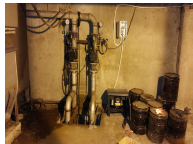
그림 6 캐비테이터 설치
