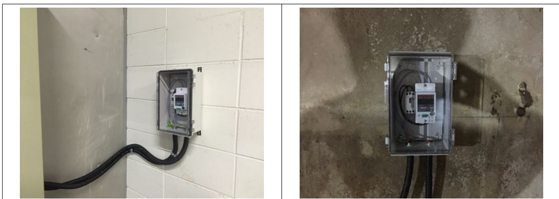
그림 15 전력량계 설치 사진
