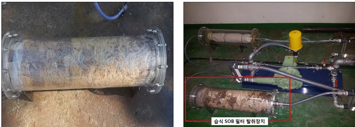
그림 10 습식 SOB 필터 탈취장치
