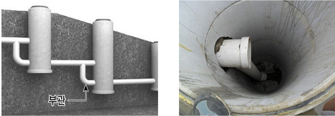
그림 12 맨홀 부관 및 부관붙임맨홀 설치
