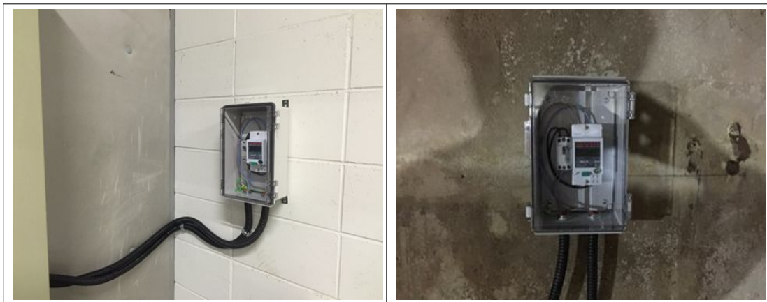
그림 18 전력량계 설치 사진
