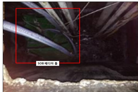
그림 4 공기주입식 SOB media장치 설치
