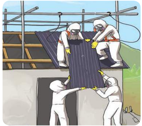
비계·안전고리 설치 및 페슬레이트 안전제거
