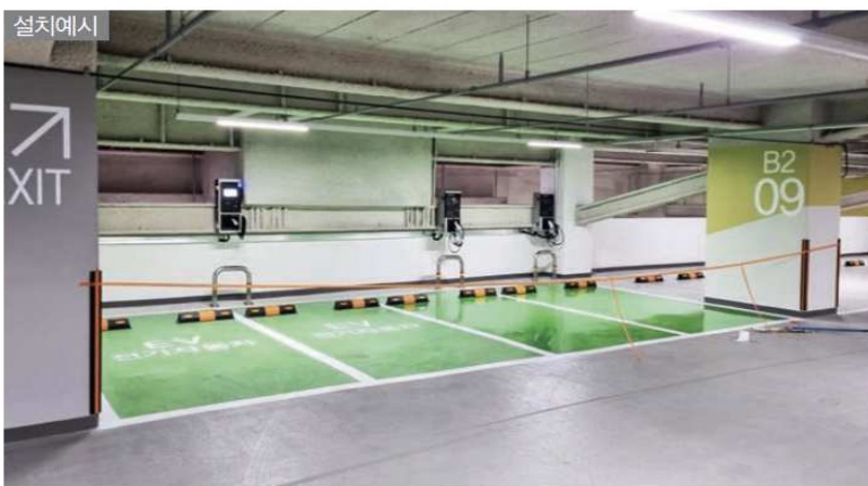
※ 충전구역의 규격은 주차장법 시행규칙 제3조제1항의 일반형 주차단위 구획을 준용하고 녹색바탕에 흰색 실선과 문자 사용
