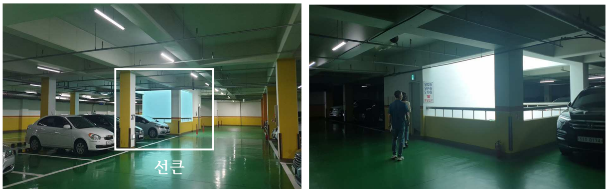
<그림 23> 선큰이 설치된 지하주차장
