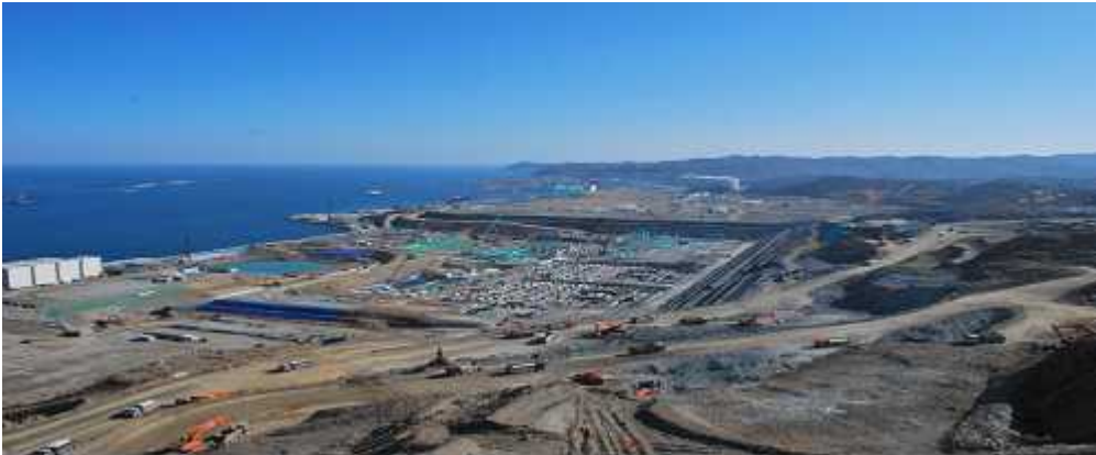
〈 종합발전단지건설 현장 I 〉
