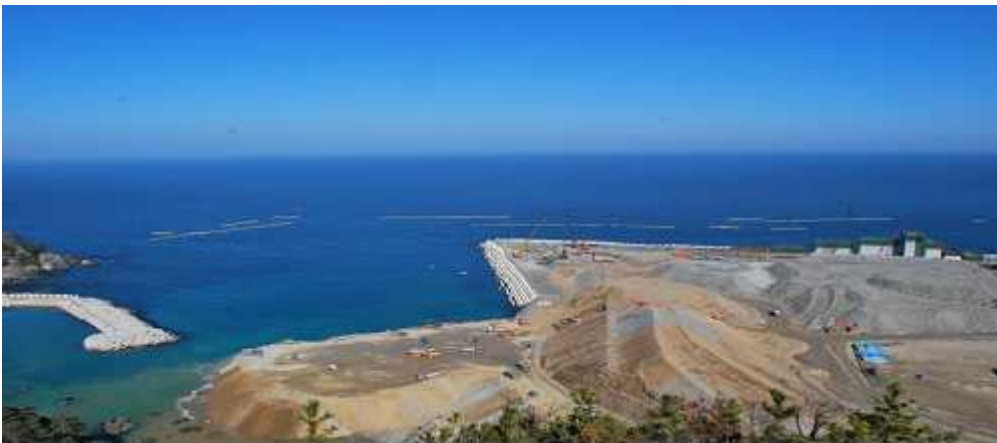
〈 종합발전단지건설 현장 II 〉
