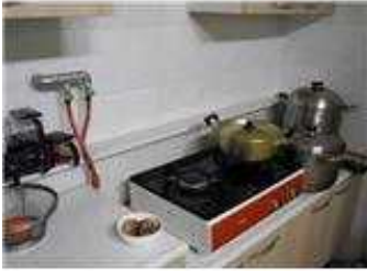
▲ 가스누설경보기가 미설치된 경우
